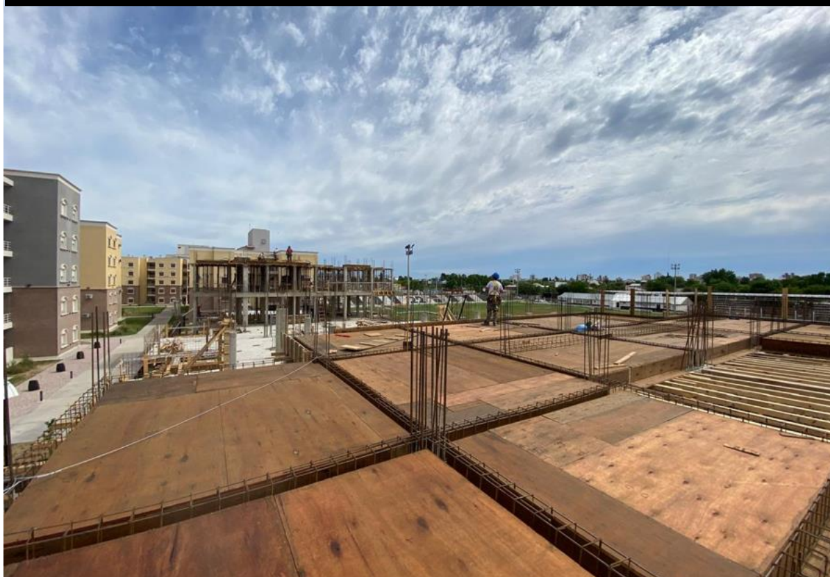
Armado de losa con encofrados y vigas. LOSA SECTOR C – PRIMER PISO
