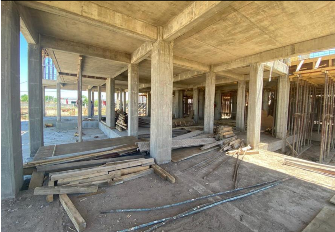
Desenfofrados para reutilización de maderas.
