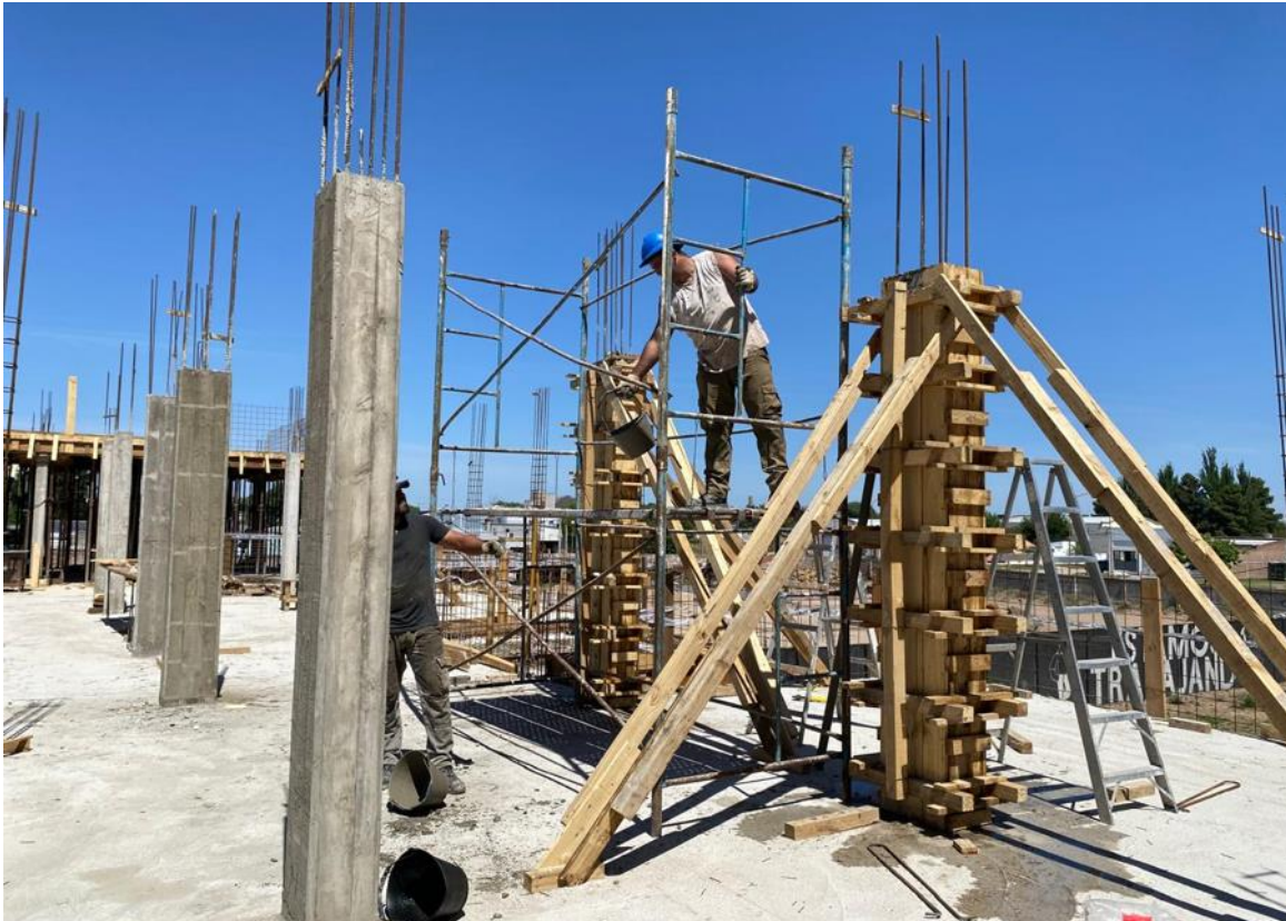
Llenado de columnas – SECTOR B – Losa Planta Baja
