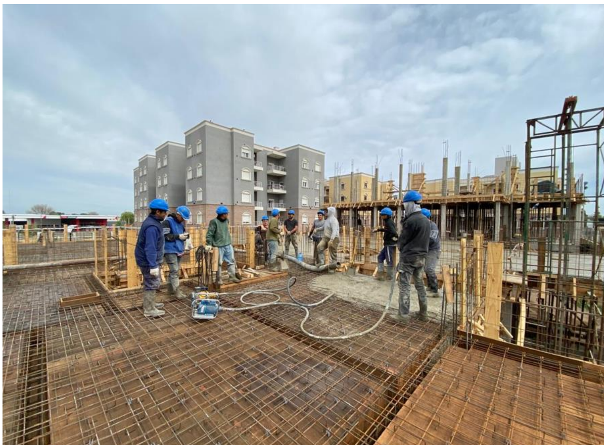
Día de Hormigón 80m3. LOSA SECTOR B – PLANTA BAJA
